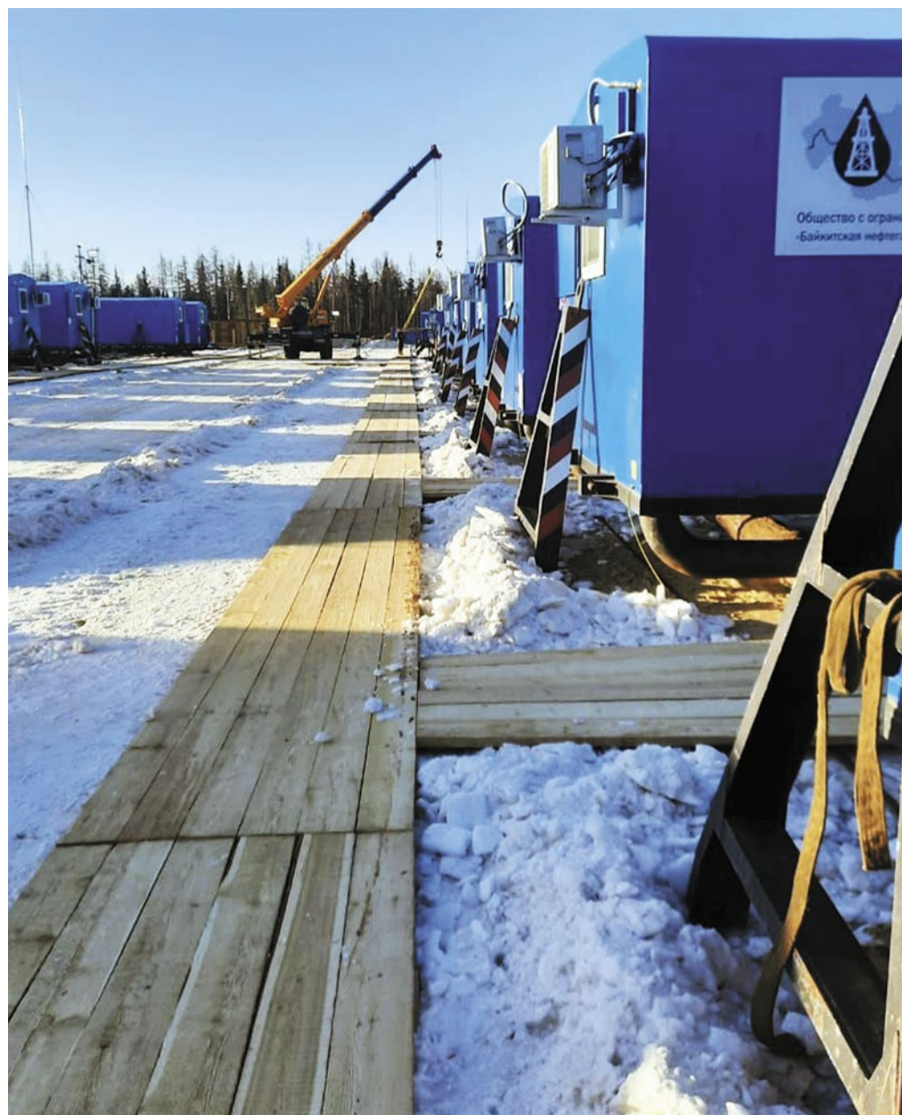
Строительство вахтового поселка на КП-75
